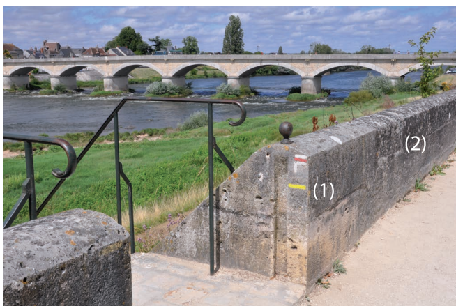
fig. 8. Les parapets de la levée. La partie en premier plan (1), de part et d'autre de l'escalier, est en calcaire lacustre. En second plan (2) le parapet est en tuffeau jaune.
