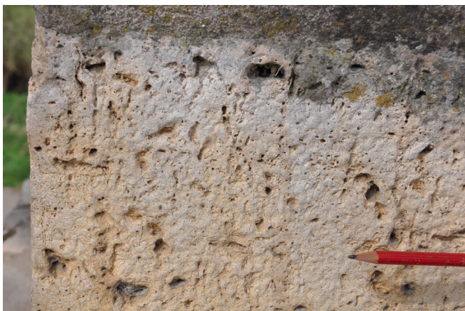
fig. 9. Aspect du calcaire lacustre dans le parapet en haut des escaliers. Ce calcaire est caractérisé par sa couleur grise et les nombreuses petites cavités qu'il renferme. Certaines de ces cavités sont dues au dégazage (formation de bulles dans le sédiment) ou à la dessiccation de la boue ; d'autres, très fines et allongées, sont les traces d'anciennes racines de plantes herbacées.
