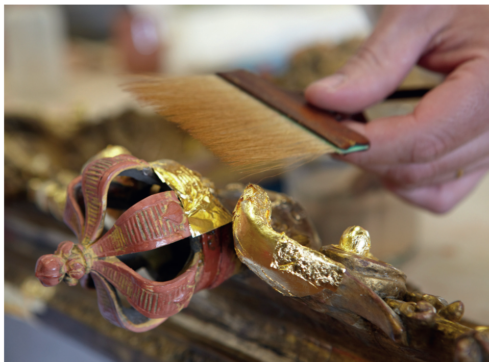
Fig. 13. La pose de la feuille – Applying gold leaf
